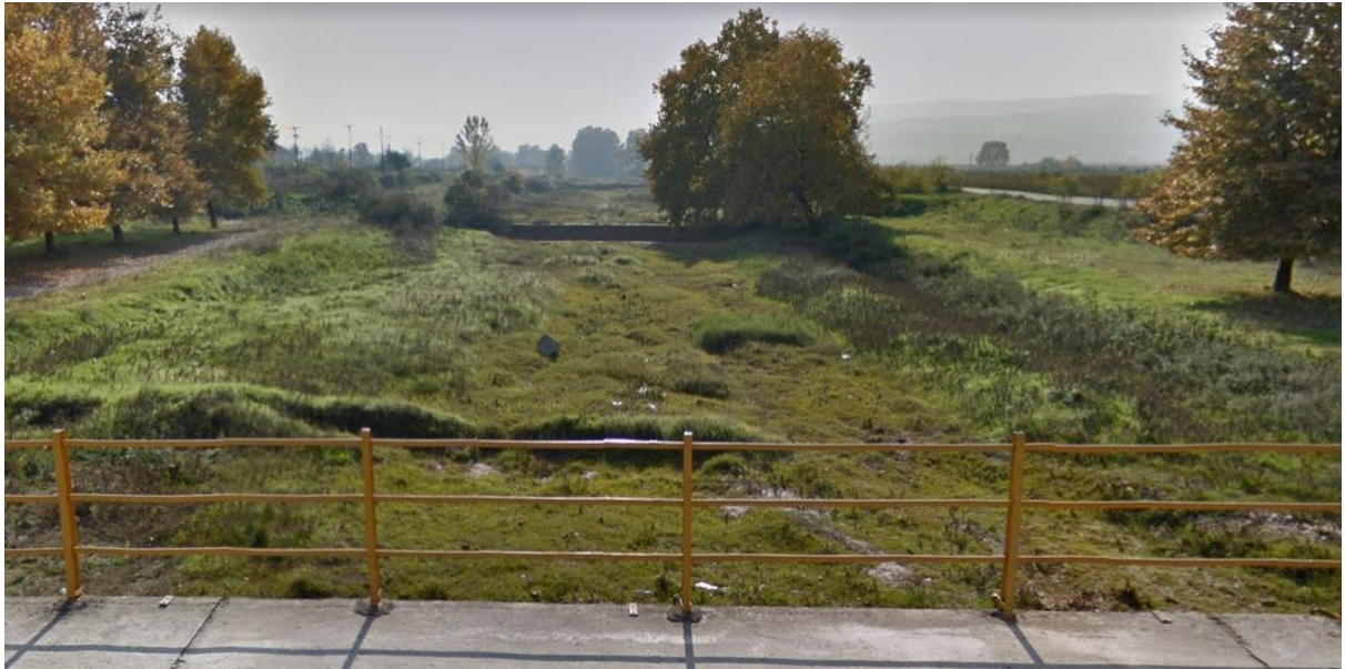
Εικόνα 4-39: Άποψη της διευθετημένης κοίτης στο ΥΣ ΕΛ0902R0002040006Η με τα φράγματα ανάσχεσης
