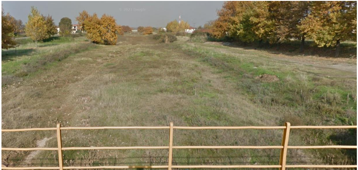
Εικόνα 4-38: Άποψη της διευθετημένης κοίτης στο ΥΣ ΕΛ0902R0002040006Η
