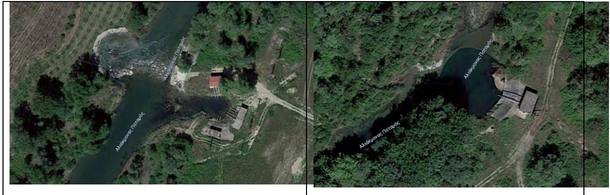
Εικόνα 4-1: Κατασκευή πρόχειρων φραγμάτων για τη λειτουργία αρδευτικών αντλιοστασίων στο ΥΣ ΕΛ0902R0002050009Η.
