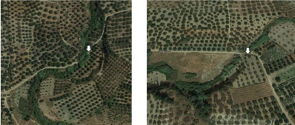
Εικόνα 4-11 : Οχετοί- κλειστά τμήματα στο ΙΤΥΣ EL1340R000106311H
