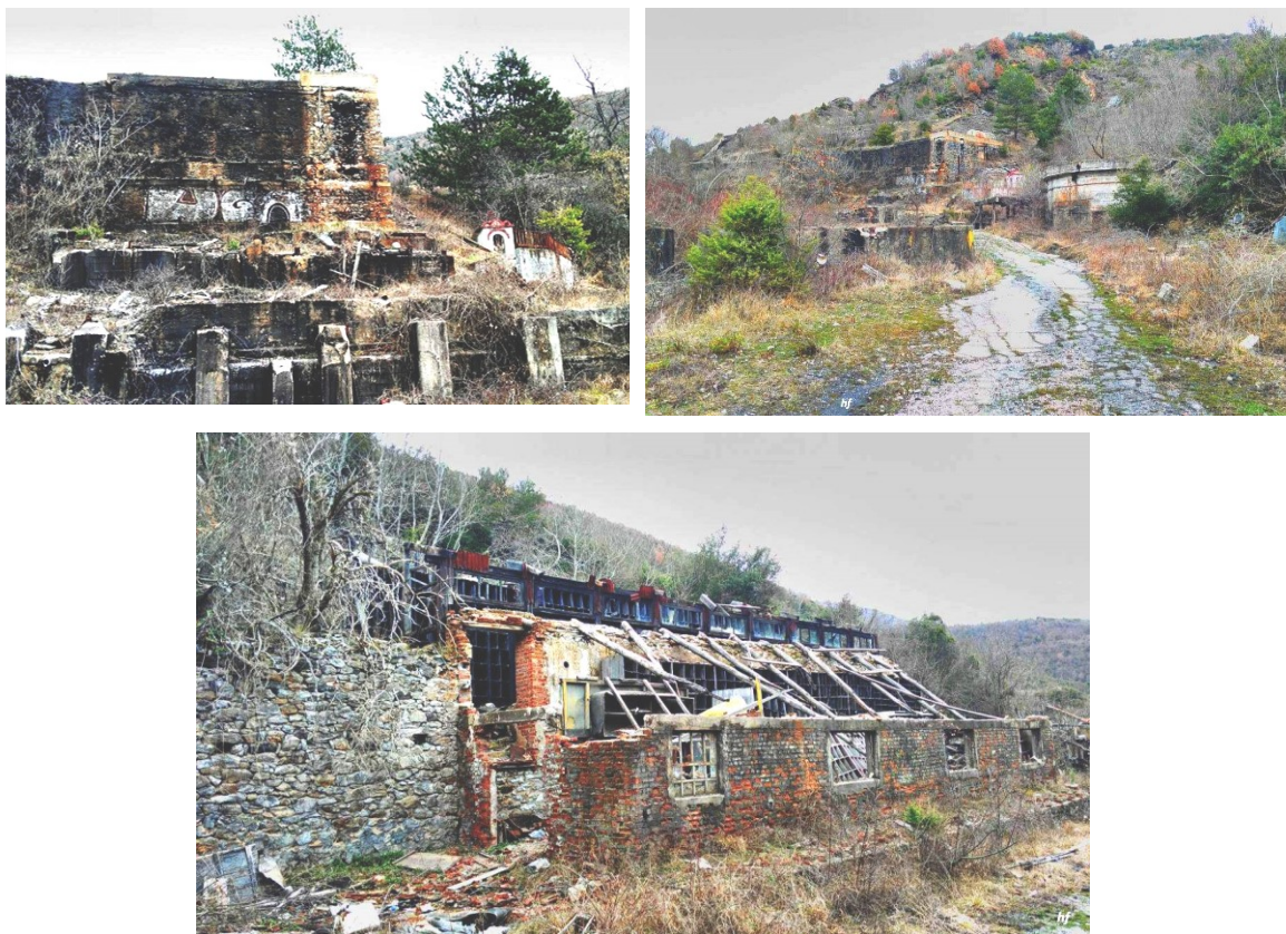
Εικόνα 3-1: Εγκαταλελειμμένες εγκαταστάσεις Μεταλλείων Βωξίτη Βώλακα Π.Ε. Δράμας.
