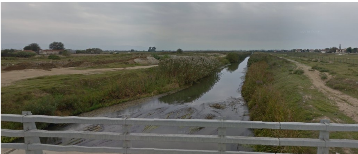
Εικόνα 4-17: EL1106R0002100242H -Η Γέφυρα Κάτω Μητρούσι-Αρχική κατασκευή 1934- Καθαρισμός τεχνικών και άρση προσχώσεων 2018-2020 (Πηγή : https://gis.consortis.gr/strimonas/ )
