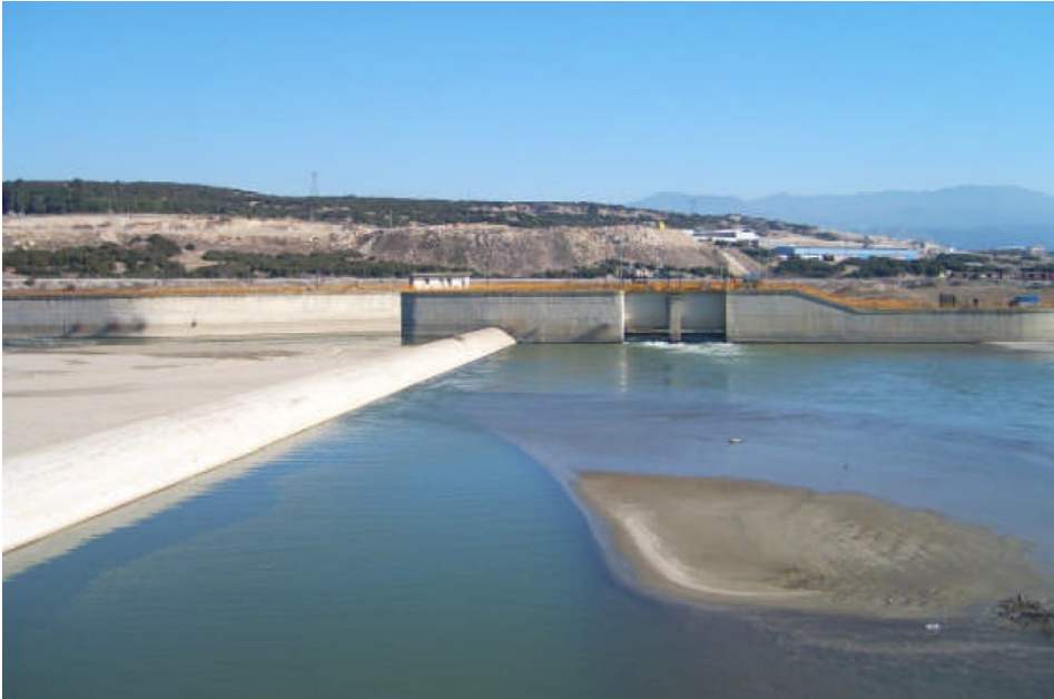
Εικόνα 5-2: Υδροληψία Υ1 (Τριμεριστής) επί του π. Στρυμόνα, πλησίον της γεφ. Σιδηροκάστρου. Από το σημείο αυτό τροφοδοτούνται τα αρδευτικά δίκτυα ΤΟΕΒ Σιδηροκάστρου και Δυτικής Διώρυγας. Πηγή: Μελέτη ΔΥΚΜ/ΑΠΘ (2008)
