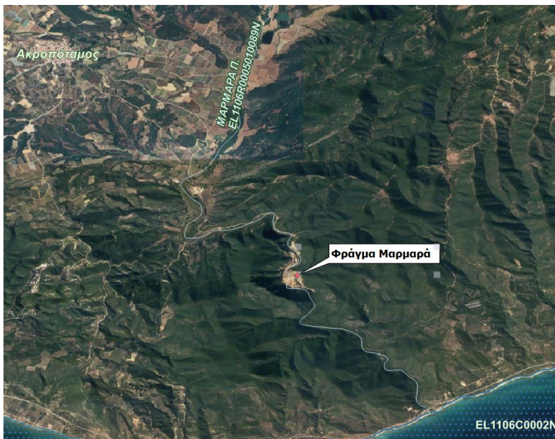
Εικόνα 4-2: Υπό κατασκευή φράγμα Μαρμαρά
