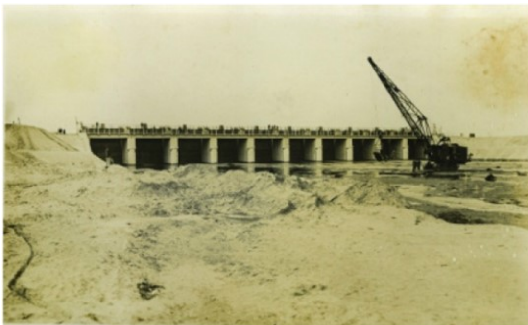
Γ.Α.Κ.- Αρχείο Ν. Σερρών. Συλλογή φωτογραφιών παραγωγικών έργων πεδιάδων Σερρών – Δράμας. «Ρουφράκτης Κερκίνης. Εσκαφεύς Δράγκλαϊν «Χείμαρρος» διερχόμενος τον Στρυμόνα κατάντη του Ρουφράκτου Κερκίνης κεκλεισμένων των θυρίδων. Μαρτίου 11, 1933».
