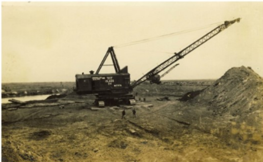
Γ.Α.Κ.- Αρχείο Ν. Σερρών. Συλλογή φωτογραφιών παραγωγικών έργων πεδιάδων Σερρών – Δράμας. Εκακαφείς Δράγκλαϊν «Νιγρίτα» και «Σιδιρόκαστρο» εκτελούντες εκτροπή προς την δεξιάν κοίτην της Νέας Κοίτης Στρυμόνος παρά το Κουβούκιον-Μαρτίου 8, 1933.
