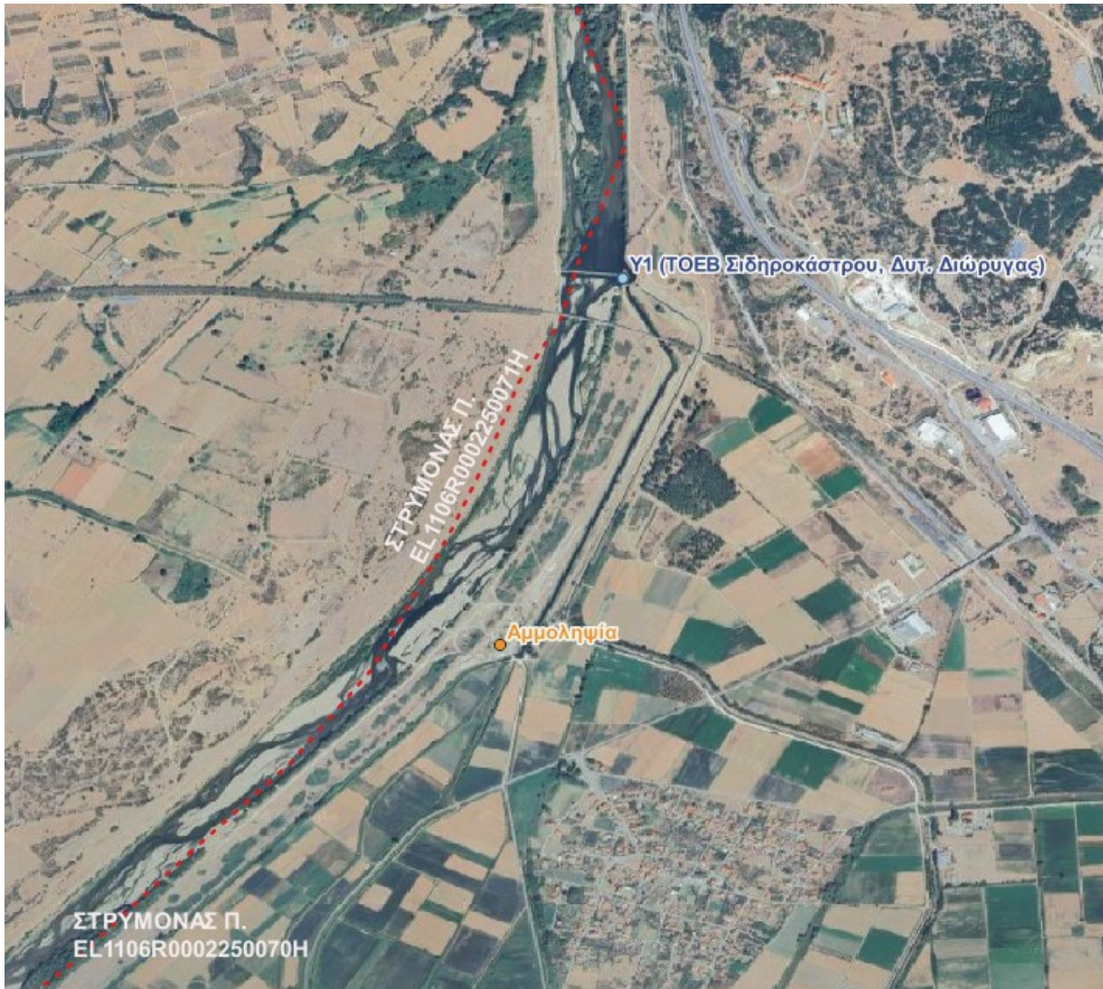
Εικόνα 4-4: Άποψη του ΥΣ EL1106R0002250071H (Στρυμόνας Π. – ανάντη Τ.Λ Κερκίνης) – Στα δεξιά διακρίνεται η Υδροληψία Υ1 και κατάντη αυτής η περιοχή αμμοληψιών. Πηγή : Google Earth
