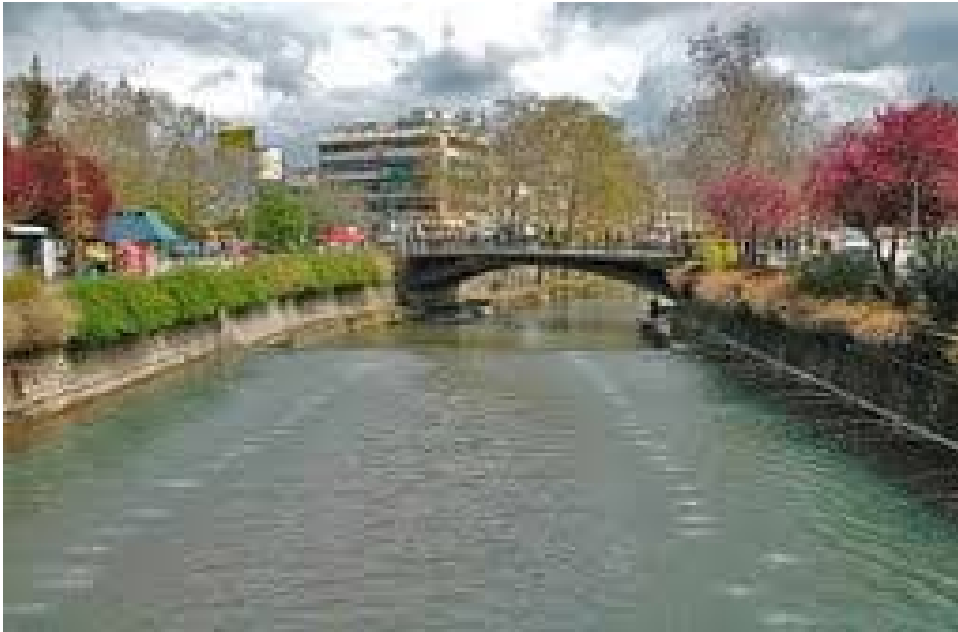
Εικόνα 3.2-5: Τμήμα του Ληθαίου που διέρχεται από την πόλη των Τρικάλων
