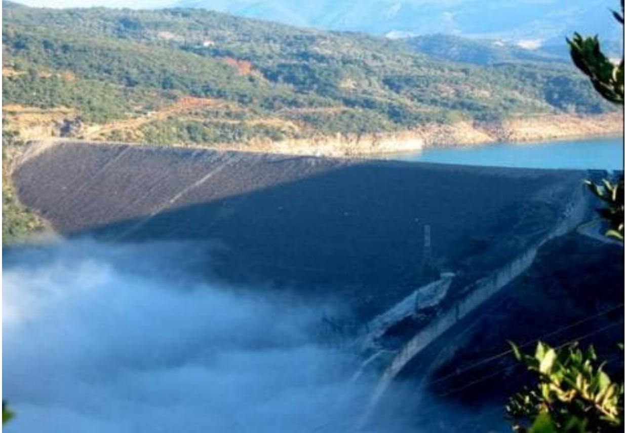
Εικόνα 3.2-3: Το φράγμα του ταμιευτήρα Κρεμαστών
