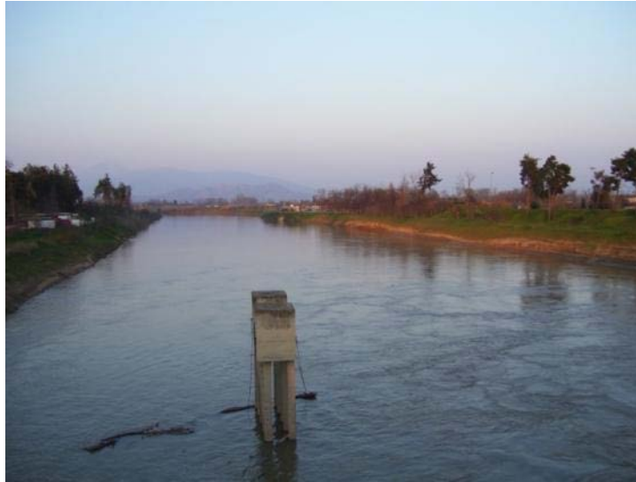
Εικόνα 3.2.1-6 Τεχνητή κοίτη Ποταμού Πηνειού περιμετρικά της πόλης της Λάρισας
