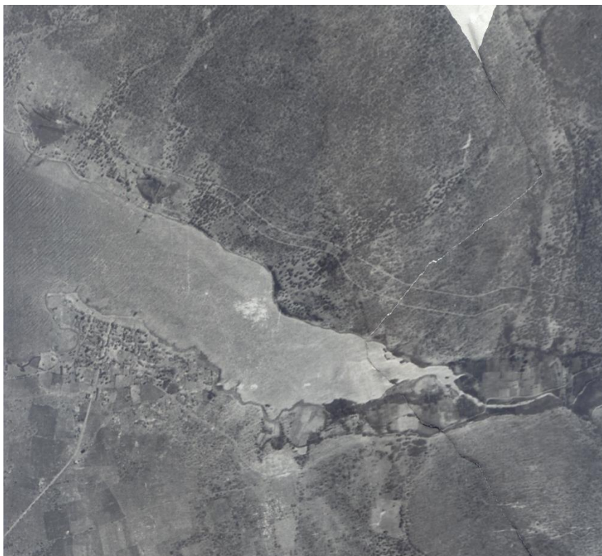
Εικόνα 3-6: Όρμος Λάρυμνας πριν την κατασκευή των λιμενικών εγκαταστάσεων
