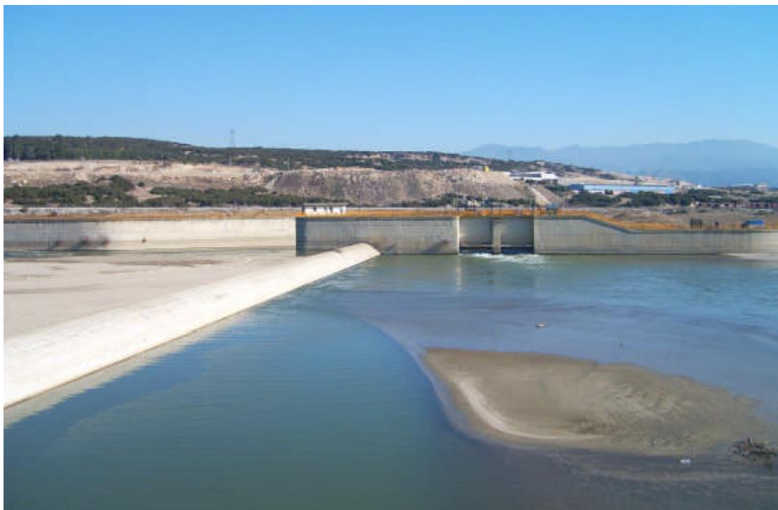
Σχήμα 3.1. Υδροληψία Υ1 (Τριμεριστής) επί του π. Στρυμόνα, πλησίον της γεφ. Σιδηροκάστρου. Από το σημείο αυτό τροφοδοτούνται τα αρδευτικά δίκτυα ΤΟΕΒ Σιδηροκάστρου, Ηρακλείας και Δυτικής Διώρυγας
