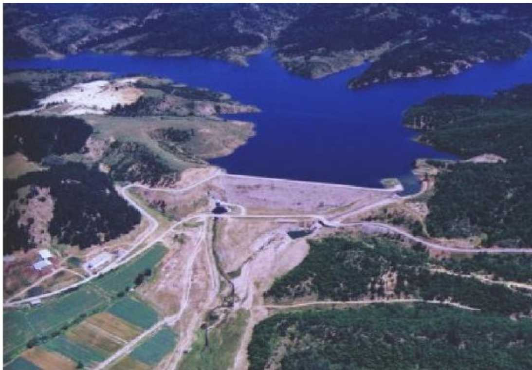
Σχήμα 3.8. Το φράγμα και η Τ.Λ. Λευκογείων, στο Δ. Κάτω Νευροκοπίου.
