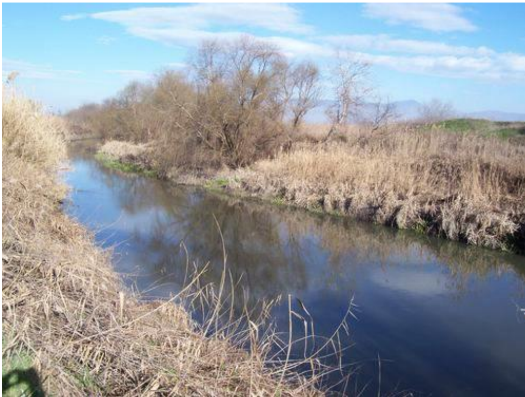
Σχήμα 3.3. Η τάφρος Μπέλιτσα. Τυπική εικόνα διευθετημένης κοίτης για αποστραγγιστικούς σκοπούς.
