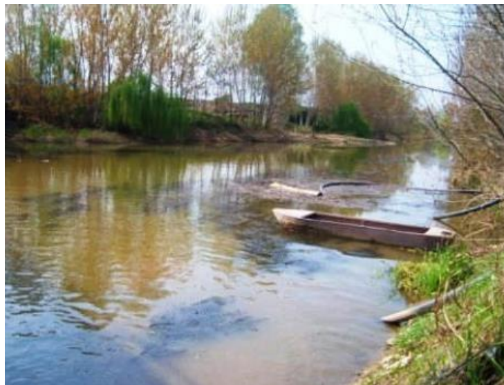
Σχήμα 3.4. Η τεχνητή Τάφρος Φιλίππων. Τεχνητό ΥΣ με σκοπό την αποστράγγιση ελώδους περιοχής. Πηγή: Μελέτη ΔΥΚΜ/ΑΠΘ (2008)
