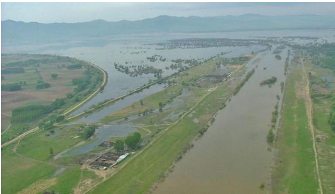
Σχήμα 3.2. Είσοδος του π. Στρυμόνα στην Τ.Λ. Κερκίνης με διευθετημένη κοίτη. Στα αριστερά διακρίνεται το πέρας του ανατολικού αναχώματος της λίμνης.
