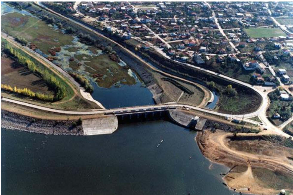
Σχήμα 3.6. Το φράγμα Λιθοτόπου στην έξοδο της Τ.Λ. Κερκίνης (άποψη από αέρος). Στα δεξιά του φράγματος διακρίνεται η υδροληψία Υ2. Κατάντη η διευθετημένη κοίτη του π. Στρυμόνα.
