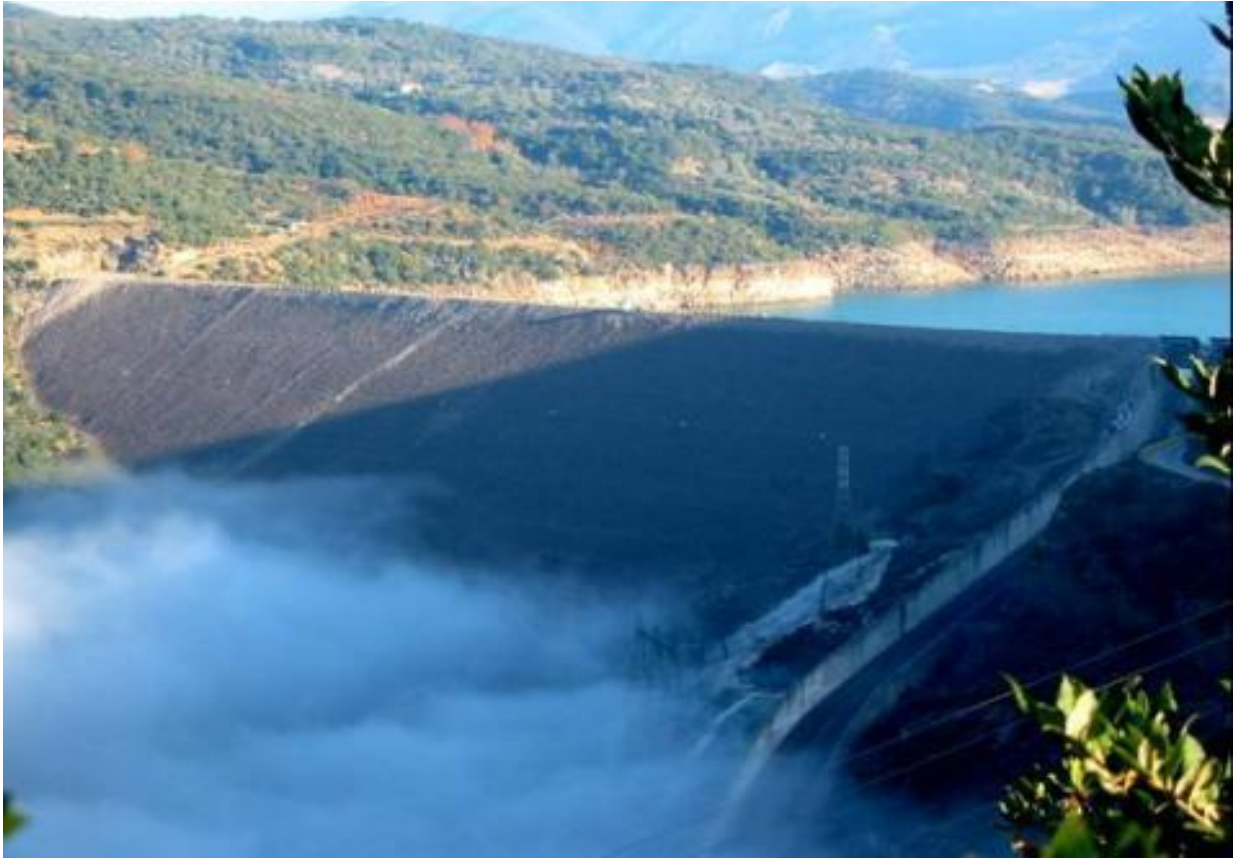
Εικόνα 3.2.1-3: Το φράγμα του ταμιευτήρα Κρεμαστών
