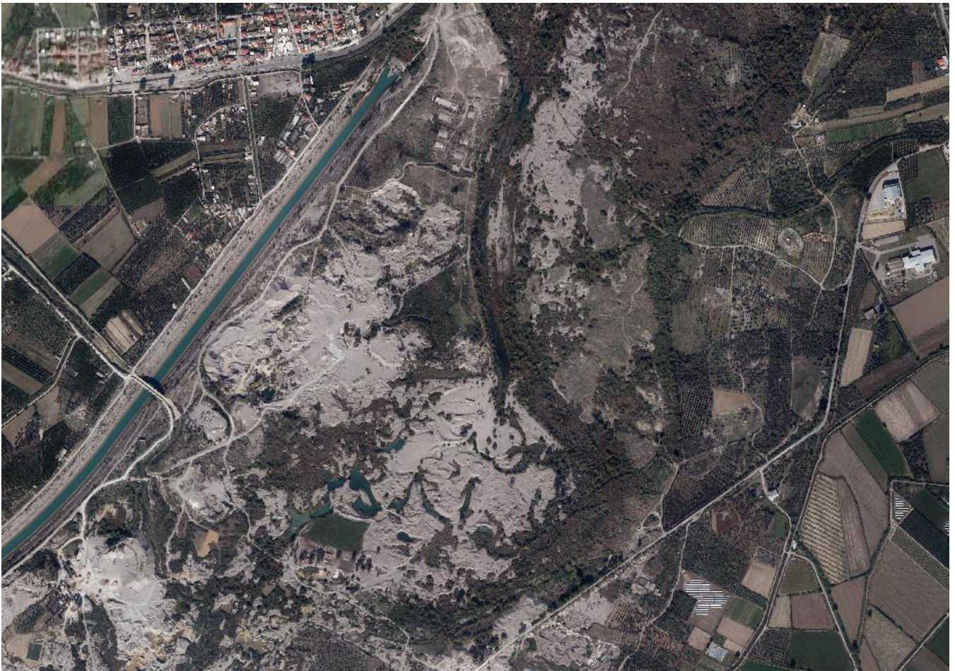
Εικόνα 3.2.1-6: Άποψη της φυσικής κοίτης του ΥΣ Αχελώος Π.5 και της διώρυγας φυγής στα δυτικά.
