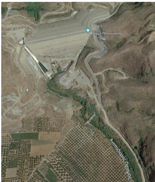
Εικόνα 4-7 : Φράγμα Πλακιώτισσας σε φάση 1 ης πλήρωσης. Έγκριση σχεδίου πλήρωσης 2020
