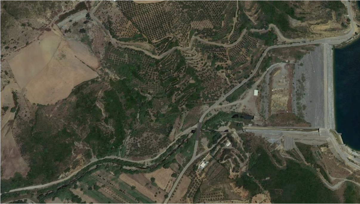
Εικόνα 4-2 : Άποψη του ΥΣ EL1339R001001063H (Ρέμα Σφακορυακό) κατάντη του φράγματος Αμαρίου Πηγή : Google Earth
