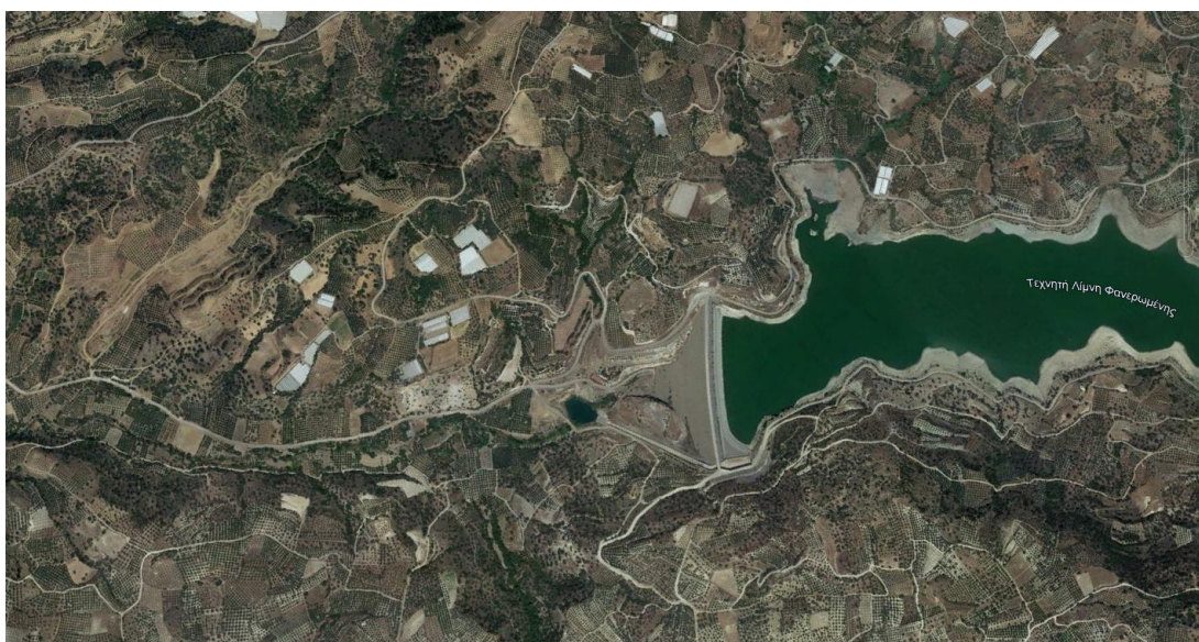
Εικόνα 4-9 : Άποψη του ΥΣ ΕΛ1340R000204124Η κατάντη Τ.Λ. Φανερωμένης (Ρέμα Γεροπόταμος)- Πηγή : Google Earth
