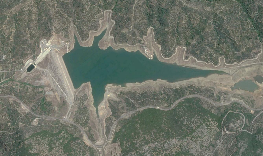
Εικόνα 5-2 : Φράγμα Αποσελέμη (πηγή : google Earth)
