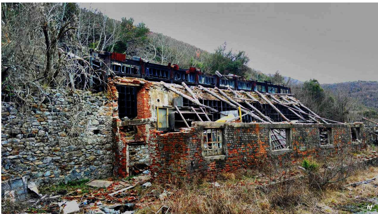
Εικόνα 4-1: Εγκαταλελειμμένες εγκαταστάσεις Μεταλλείων Βωξίτη Βώλακα Π.Ε. Δράμας.
