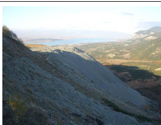
Εικόνα 3-2: Τα στείρα προϊόντα είτε αυτά που είχαν μικρή περιεκτικότητα σε αμιάντο, αποτέθηκαν σε διάφορους αποθεσιοθάλαμους.
