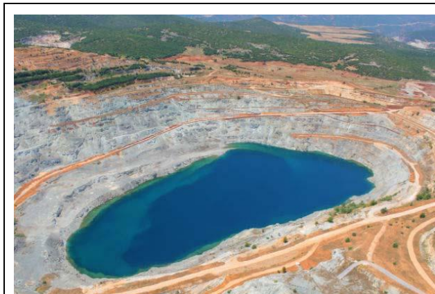
Εικόνα 3-1: Λατομείο MABE: Μετά την παύση των εργασιών στην περιοχή εκμετάλλευσης έχει δημιουργηθεί μία λίμνη 155 στρ.
