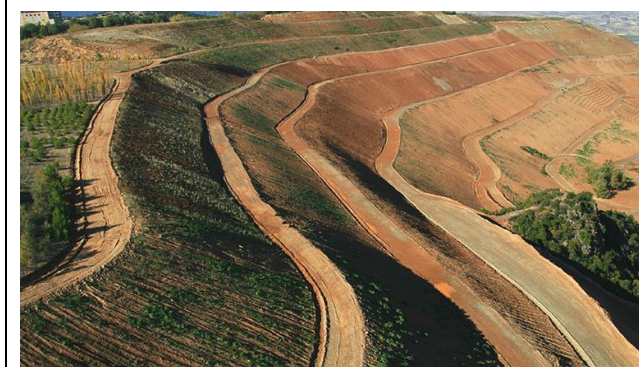
Εικόνα 3-3: Εργασίες αποκατάστασης στους αποθεσιοθάλαμους στείρων υλικών.
