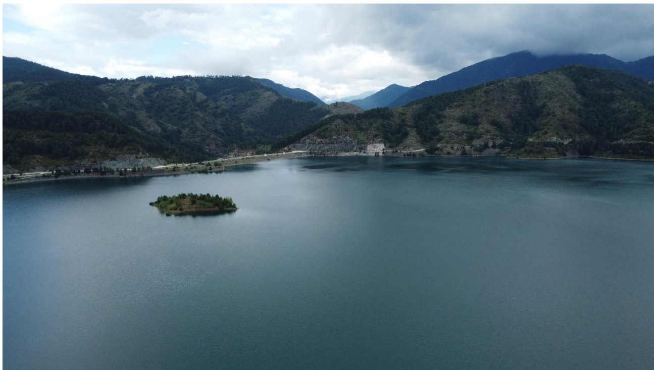
Εικόνα 3.2.1-1: Τεχνητή Λίμνη Πηγών Αώου
