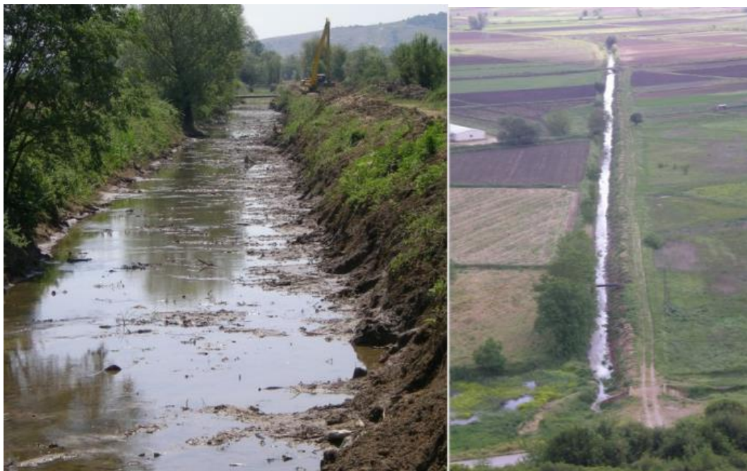
Εικόνα 3.2.2-5: Η τάφρος Λαψίστας
