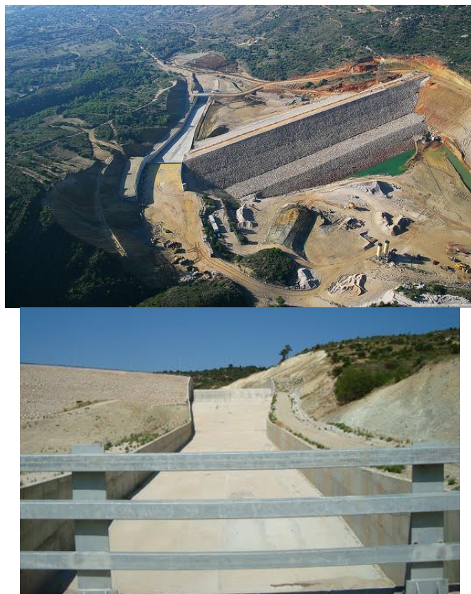
Εικόνα 4-1 Φράγμα Καλαμωτής στα ανάντη του ΥΣ EL1436R003300027H (ρ.Φανοπούργων)
