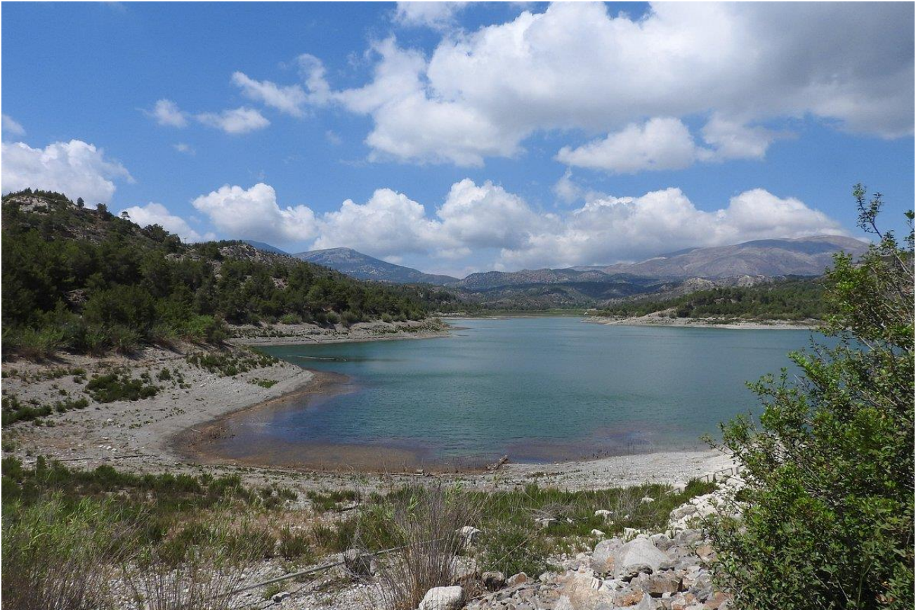
Εικόνα 4-4 Φράγμα Απολακκιάς στα ανάντη του ΥΣ EL1438R000600073H (ρ.Σιανίτης)
