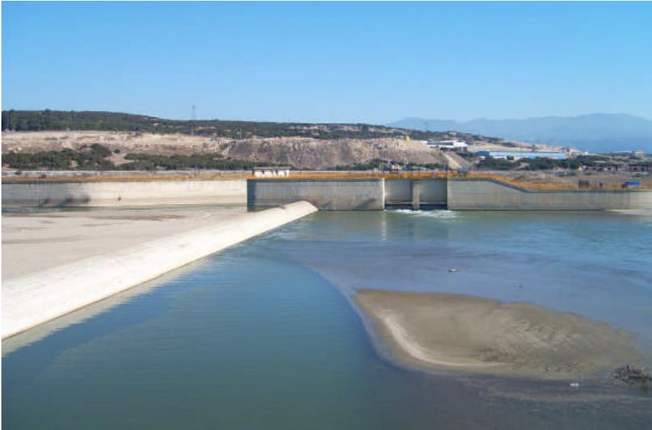
Εικόνα 5-1 Υδροληψία Υ1 (Τριμεριστής) επί του π. Στρυμόνα, πλησίον της γεφ. Σιδηροκάστρου. Από το σημείο αυτό τροφοδοτούνται τα αρδευτικά δίκτυα ΤΟΕΒ Σιδηροκάστρου και Δυτικής Διώρυγας. Πηγή: Μελέτη ΔΥΚΜ/ΑΠΘ (2008)
