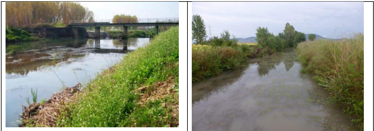
Εικόνα 5-4 Η τεχνητή Τάφρος Φιλίππων. Τεχνητό ΥΣ με σκοπό την αποστράγγιση ελώδους περιοχής. Πηγή: Μελέτη ΔΥΚΜ/ΑΠΘ (2008), Το Γκαβόχελο, η Γραμβοβελονίτσα και τα τενάγη των Φιλίππων - dasarxeio.com
