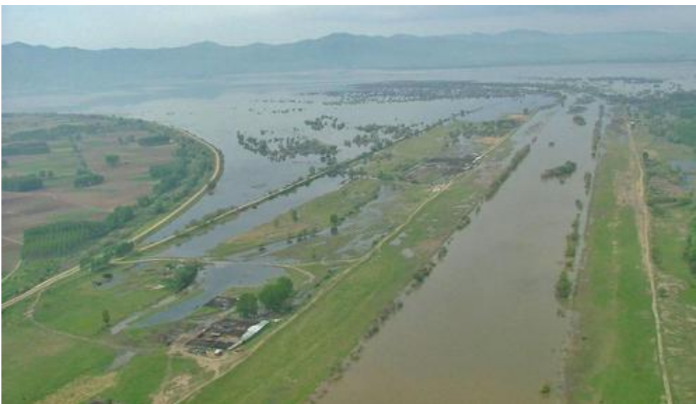
Εικόνα 5-2 Είσοδος του π. Στρυμόνα στην Τ.Λ. Κερκίνης με διευθετημένη κοίτη. Στα αριστερά διακρίνεται το πέρασ του ανατολικού αναχώματος της λίμνης. Πηγή: http://www.panoramio.com/user/1730549?with_photo_id=10228059
