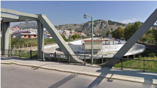
Εικόνα 4-21: Ανάντη Γέφυρας Σιδηροκάστρου
