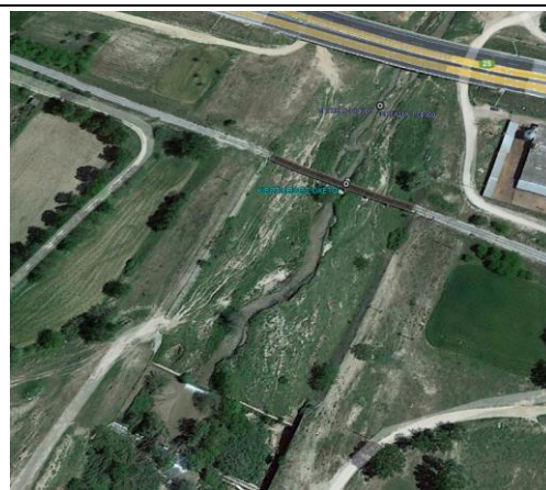
Εικόνα 4-14: EL1106R0002100245H : Αναβαθμοί και κιβωτοειδείς οχετοί κατάντη της γέφυρας Α25-Κρούσοβιτη
