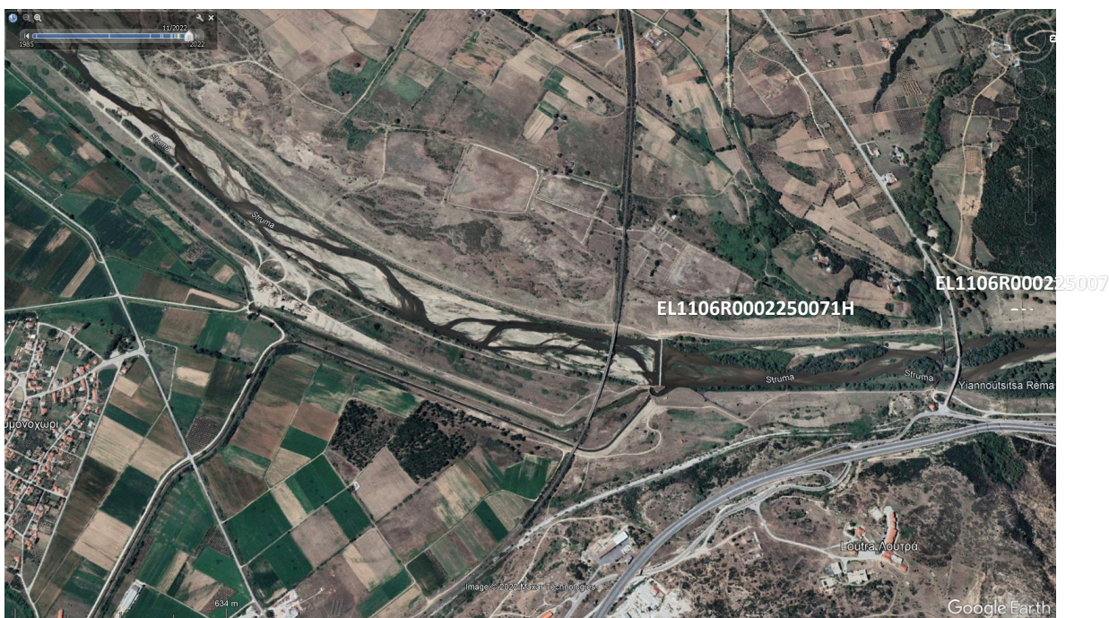
Εικόνα 4-2: Άποψη του ΥΣ EL1106R0002250071H (Στρυμόνας Π. - ανάντη Τ.Λ Κερκίνης) – Στα δεξιά διακρίνεται η Υδροληψία Y1 και κατάντη αυτής η περιοχή αμμοληψιών. Πηγή : Google Earth
