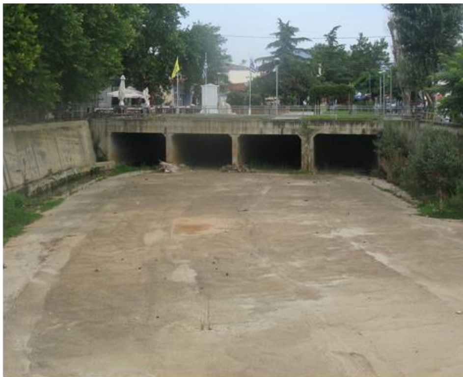
Εικόνα 3-5: Ποταμός Ανθεμόντας – υπογειοποίηση στον οικισμό Βασιλικών
