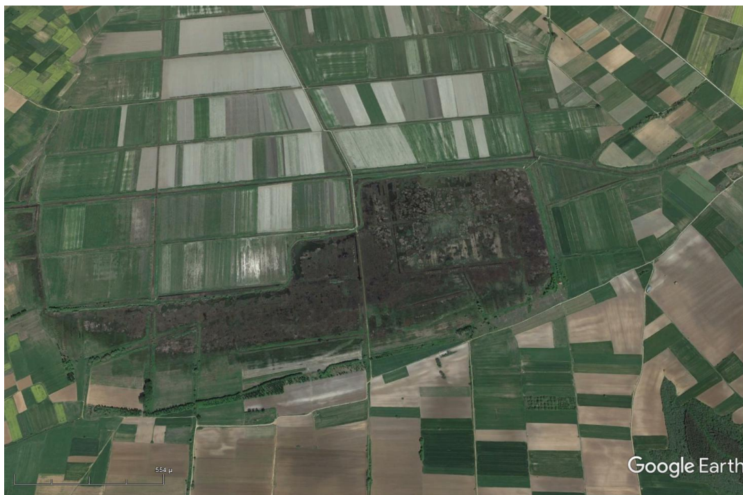
Εικόνα 3-26: Περιοχή υγροτοπικού συστήματος (πηγή: google earth)
