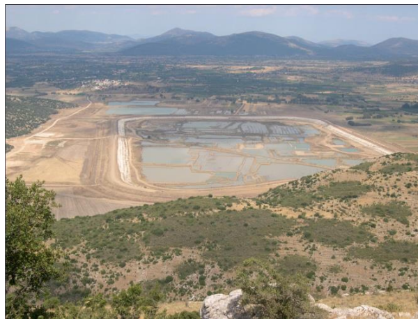
Υπό κατασκευή τεχνητή λίμνη Τάκα
