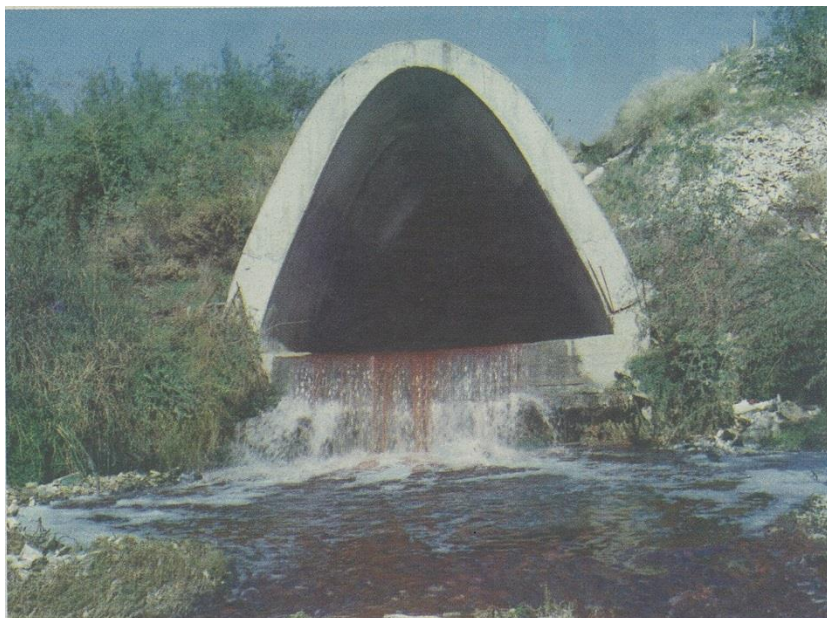
Εικόνα 3-11: Έξοδος κλειστού αγωγού Ρ. Πύρνας - όψη προς τα ανάντη (πηγή: ΕΥΔΑΠ)
