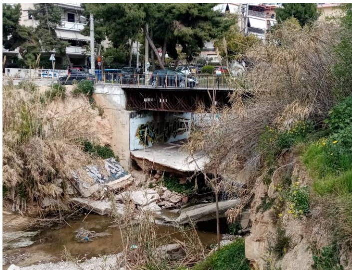
Εικόνα 3-14 Γέφυρα οδού Κουντουριώτου 12
