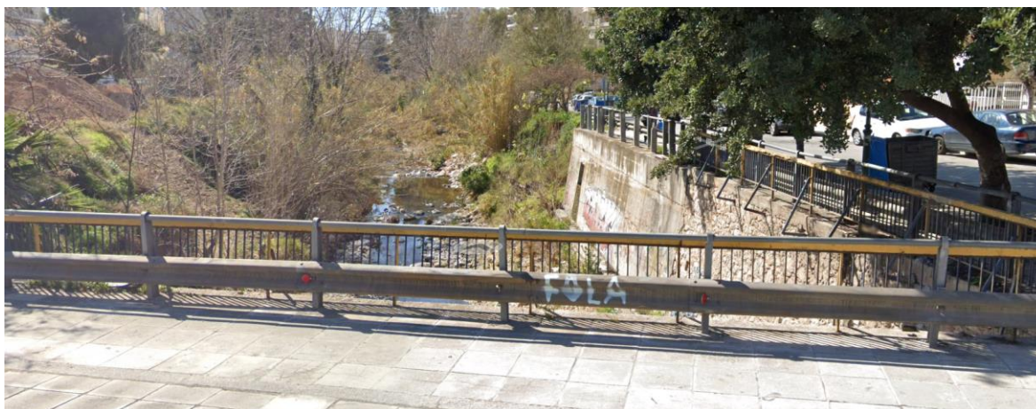
Εικόνα 3-15 Γέφυρα κατάντη λεωφόρου Αμφιθέας (google street map)
