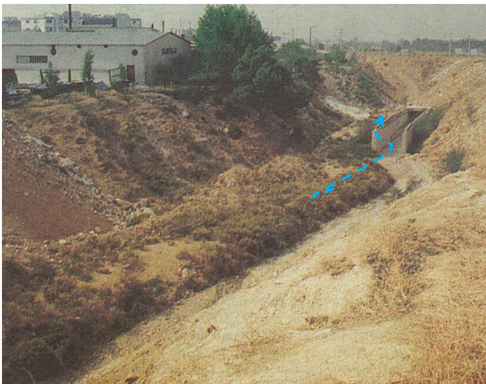
Εικόνα 3-10: Είσοδος Οχετού Πύρνας ανάντη Εθνικής Οδού - όψη προς τα κατόντη (Πηγή: ΕΥΔΑΠ)
