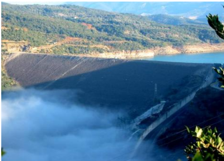
Εικόνα 3.2.1-2: Το φράγμα του ταμιευτήρα Κρεμαστών
