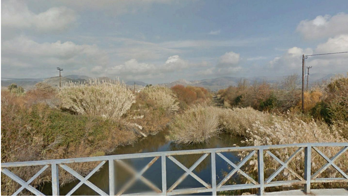
Εικόνα 6-3 Χωματοουργική Διευθέτηση ρ. Χαλάντρα. Φωτογραφικές λήψεις από γέφυρα πριν την εκβολή του ρέματος στη θάλασσα (Google Earth, Street View)
