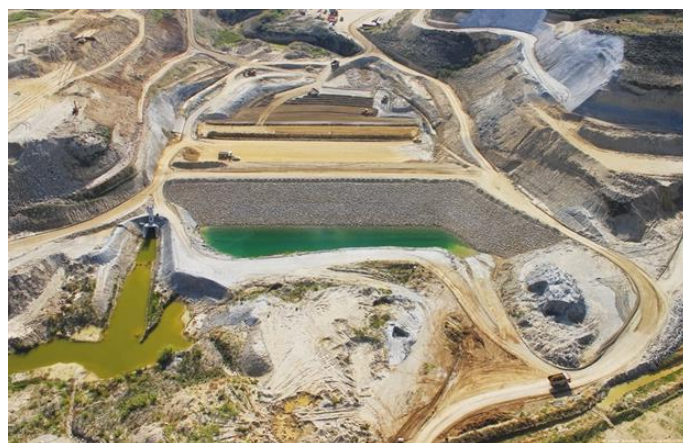
Εικόνα 5-8 Φράγμα Πλακιώτισσας (υπό κατασκευή)
