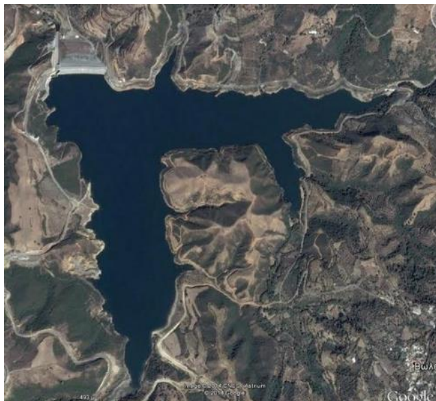
Εικόνα 5-3 Φράγμα Ποταμών Αμαρίου
