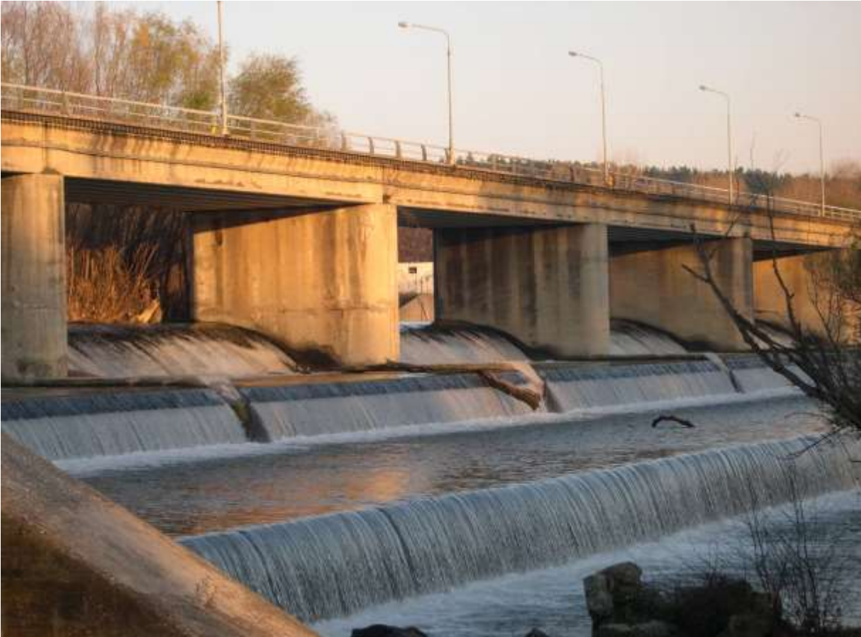
Εικόνα 4-1. Ρουφράκτης Τοξοτών επί του π. Νέστου. Από το σημείο αυτό τροφοδοτούνται τα αρδευτικά δίκτυα ΤΟΕΒ Θαλασσιάς-Κρεμαστής (Ξάνθη) και Χρυσούπολης, Χρυσοχωρίου (Καβάλα).
