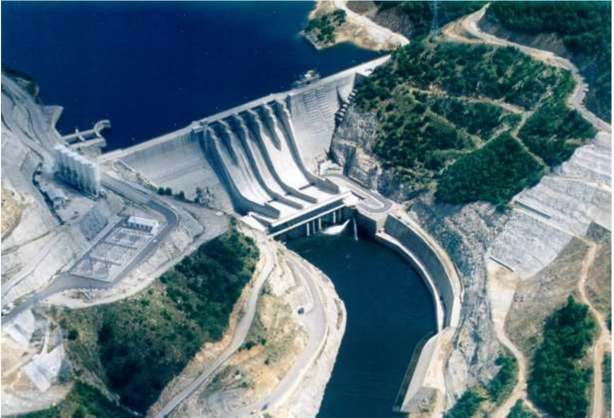
Εικόνα 4-3. ΥΗΕ Πλατανόβρυσης στον π. Νέστο.
