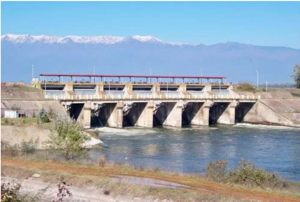
Εικόνα 4-5. Το φράγμα Λιθοτόπου στην έξοδο της Τ.Λ. Κερκίνης.
