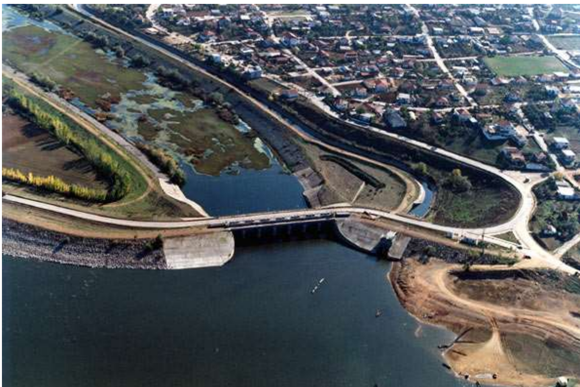
Εικόνα 4-6. Το φράγμα Λιθοτόπου από ψηλά. Στα δεξιά βρίσκεται η υδροληψία Υ2 που τροφοδοτεί τα αρδευτικά δίκτυα δυτικά του Στρυμόνα (ΤΟΕΒ Στρυμονικού- Δημητρίτσιου, ΤΟΕΒ Νιγρίτας, Δίκτυο Αχινού-Μαυροθάλασσας του ΓΟΕΒ Πεδιάδας Σερρών).
