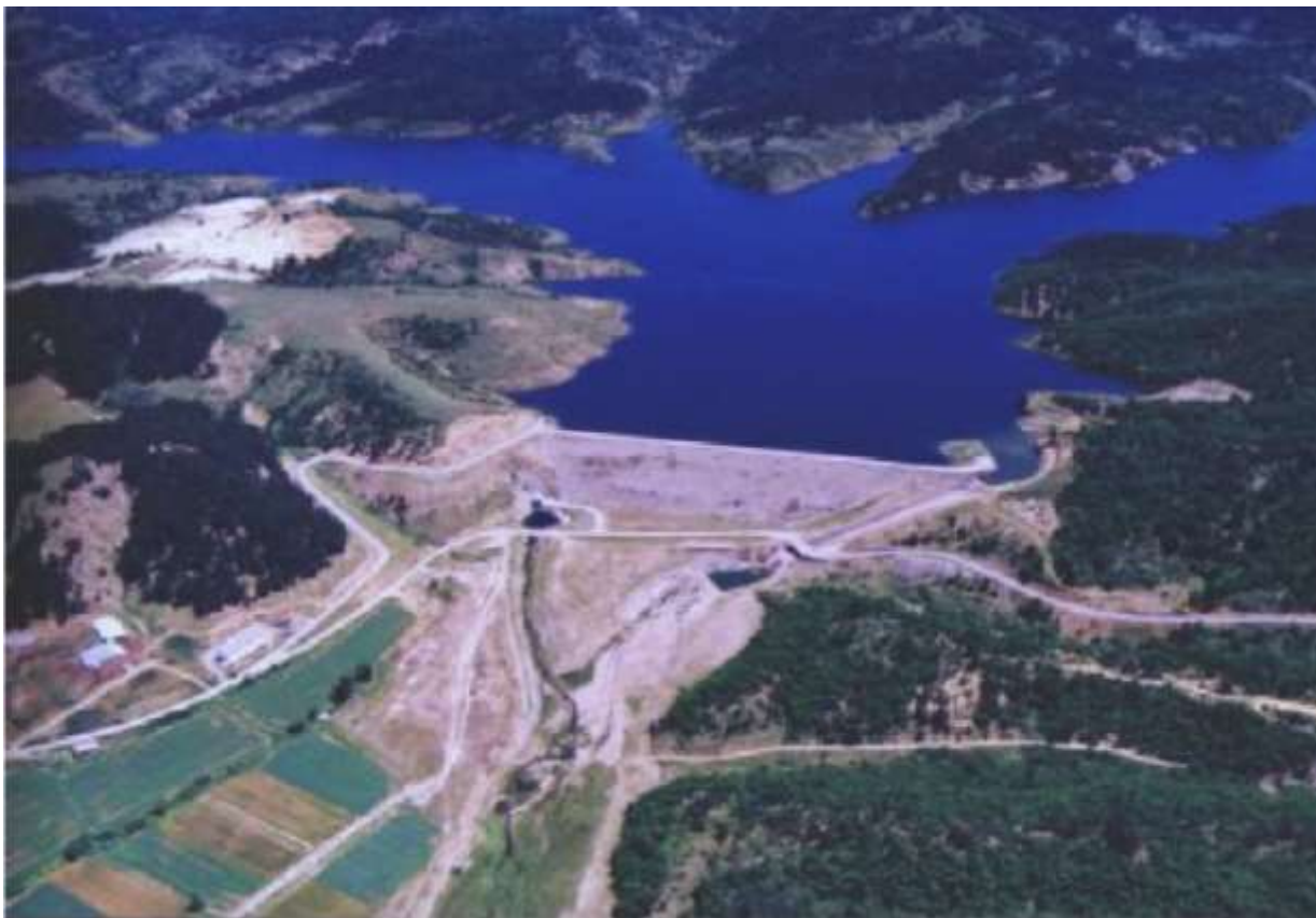
Εικόνα 4-7. Το φράγμα και η Τ.Λ. Λευκογείων, στο Δ. Κάτω Νευροκοπίου.
