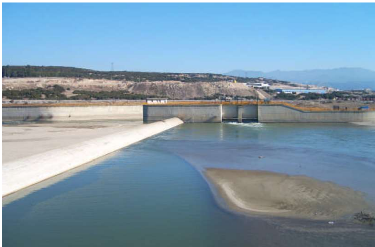
Εικόνα 4-1. Υδροληψία Υ1 (Τριμεριστής) επί του π. Στρυμόνα, πλησίον της γεφ. Σιδηροκάστρου. Από το σημείο αυτό τροφοδοτούνται τα αρδευτικά δίκτυα ΤΟΕΒ Σιδηροκάστρου και Δυτικής Διώρυγας
