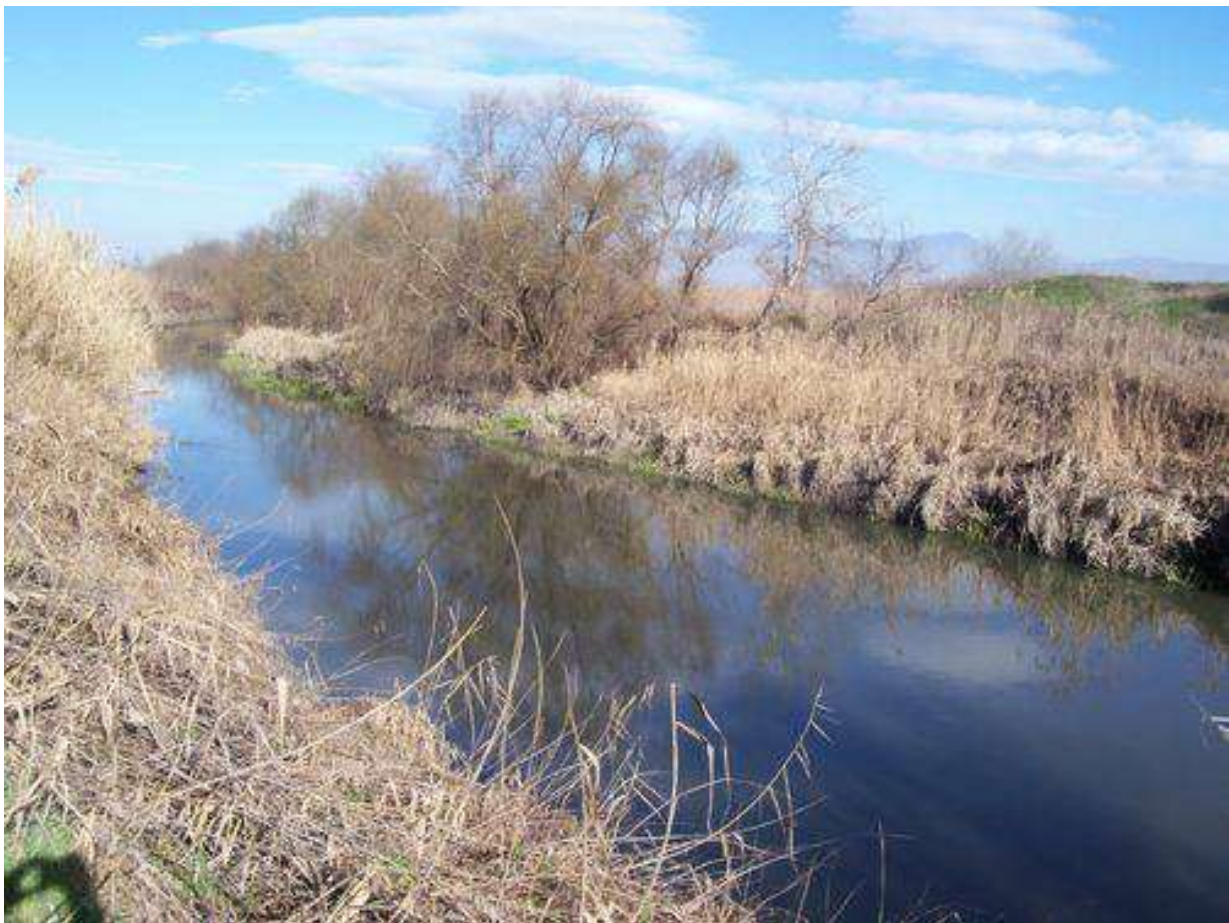
Εικόνα 4-3. Η τάφρος Μπέλιτσα. Τυπική εικόνα διευθετημένης κοίτης για αποστραγγιστικούς σκοπούς.
