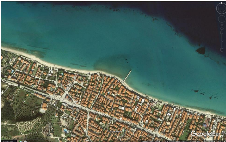
Εικόνα 5-36: Δορυφορική εικόνα σκάλας επιβίβασης Πευκοχωρίου της ΠΕ Χαλκιδικής (πηγή: Google Earth)
