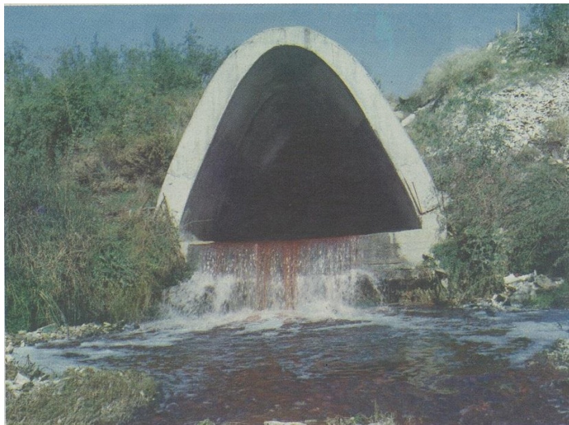
Εικόνα 3-5: Έξοδος κλειστού αγωγού Ρ. Πύρνας - όψη προς τα ανάντη (πηγή: ΕΥΔΑΠ)
