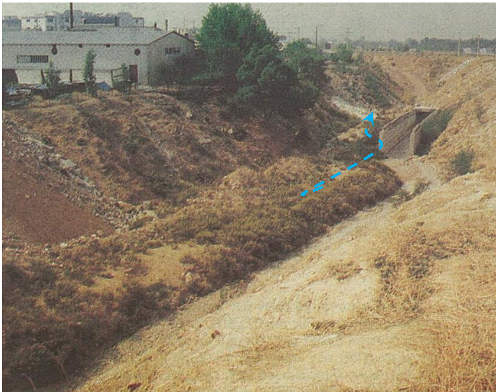
Εικόνα 3-4: Είσοδος Οχετού Πύρνας ανάτη Εθνικής Οδού - όψη προς τα κατάντη (Πηγή: ΕΥΔΑΠ)
