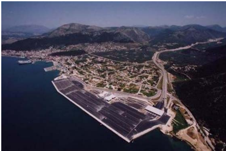
Εικόνα 3.2.2.6-1 Ο λιμένας Ηγουμενίστας
