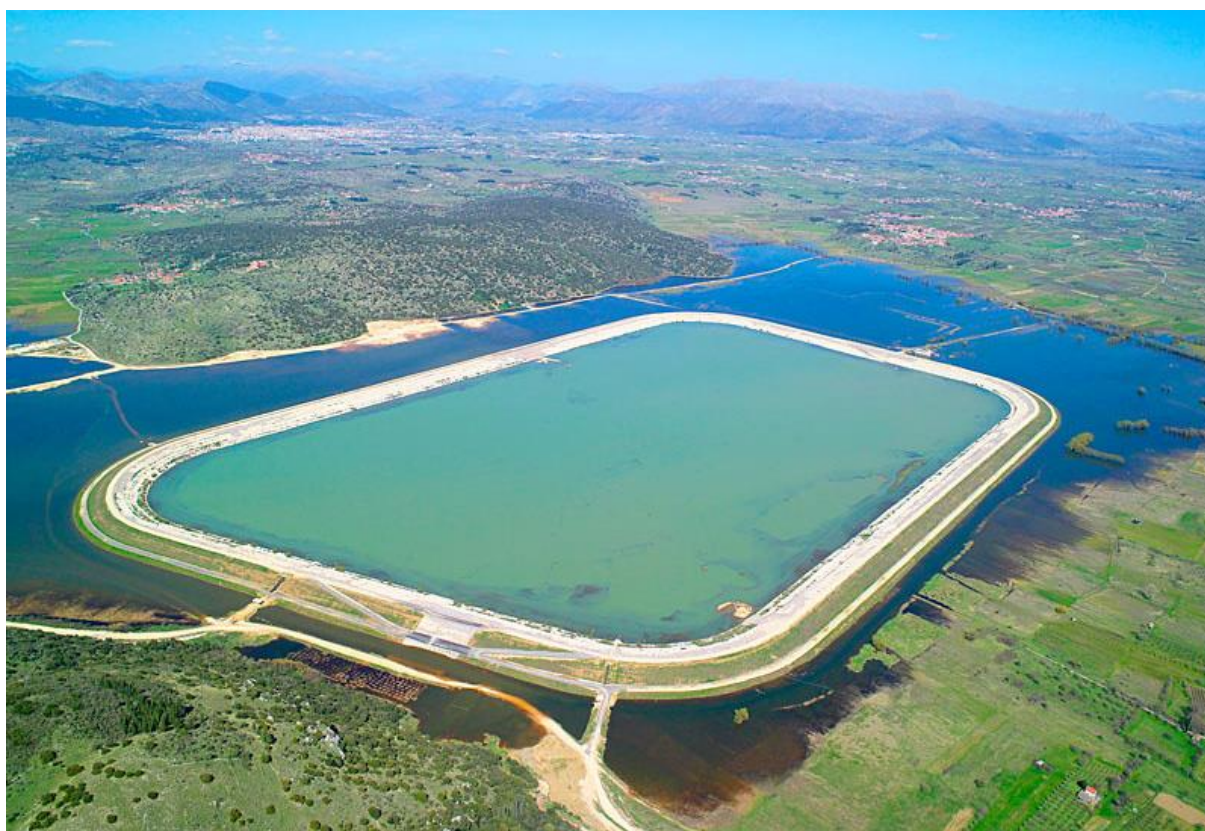
Σχήμα 3-2 .Φωτογραφίες από τη λίμνη Τάκα, πριν κατά και μετά την κατασκευή των έργων
