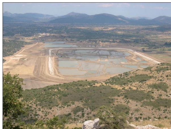
Υπό κατασκευή τεχνητή λίμνη Τάκα
