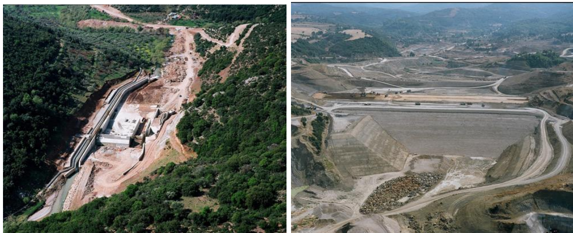
Σχήμα 3-13. Έργα κατασκευής του φράγματος Αστερίου στον ποταμό Παραπίερο
