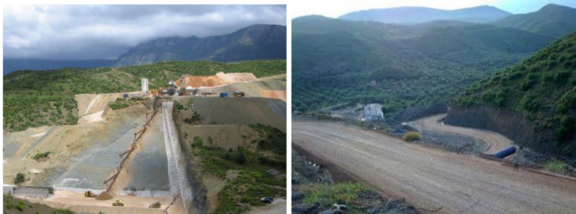
Σχήμα 3-9. Φωτογραφίες από την κατασκευή του φράγματος Φιλιατρινού και την έναρξη πλήρωσης του (καλοκαίρι 2017)
