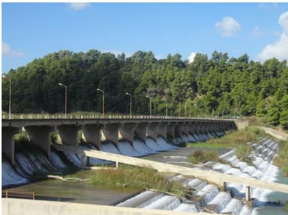
Σχήμα 3-2 Φωτογραφία φράγμα Φλόκα
