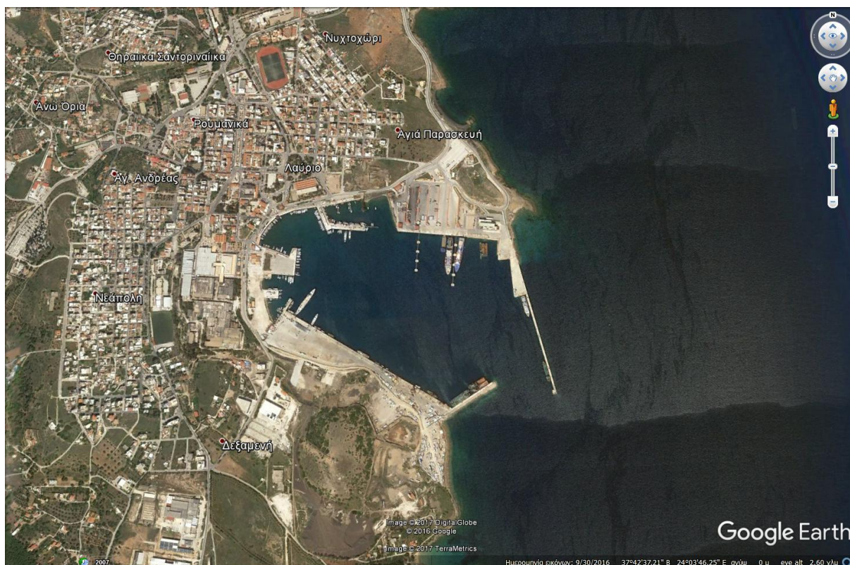
Σχήμα 2-20 Δορυφορική Εικόνα Λιμένα Λαυρίου (πηγή: Google Earth)
