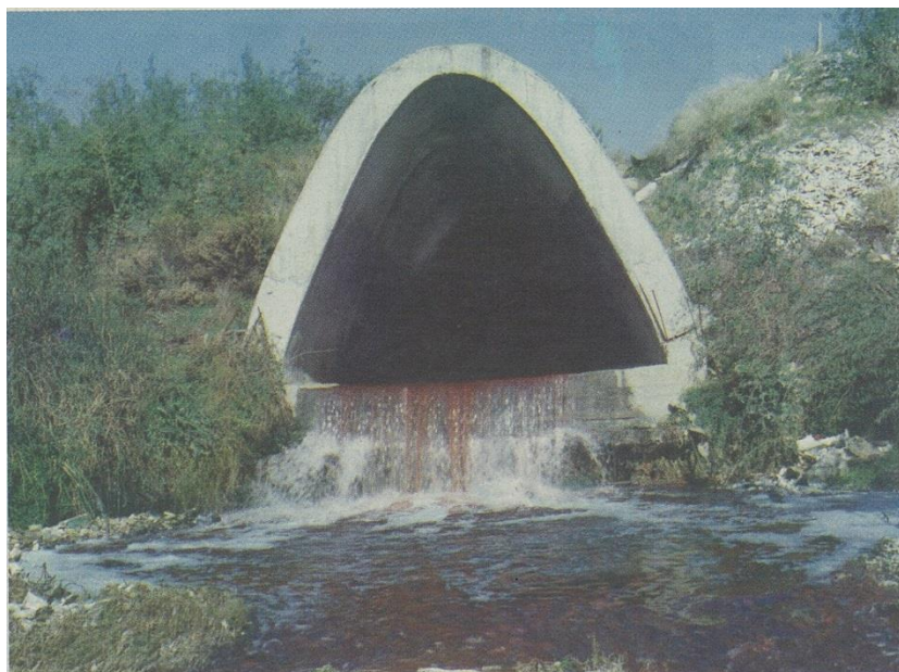
Σχήμα 2-15 Έξοδος κλειστού αγωγού Ρ. Πύρνας - όψη προς τα ανάντη (πηγή: ΕΥΔΑΠ)
