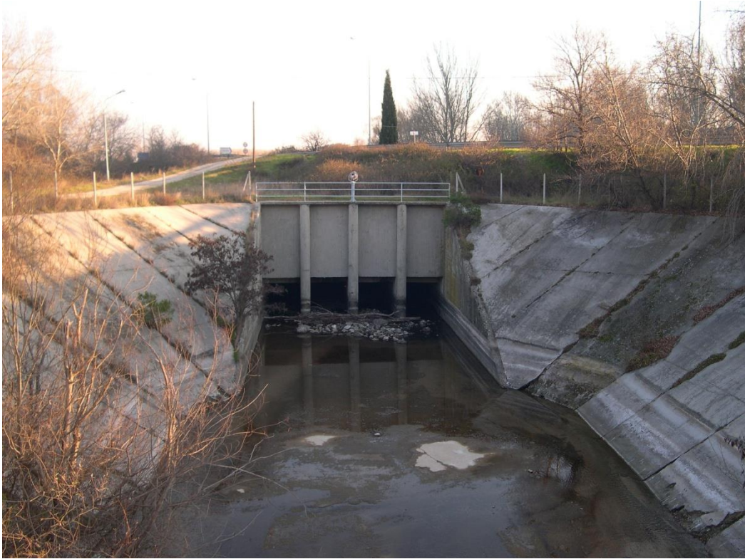
Σχήμα 3.2. Υδροληψία φράγματος Τοξοτών επί του π. Νέστου. Υπάρχουν δύο τέτοιες διατάξεις στο φράγμα Τοξοτών, η ανατολική και η δυτική υδροληψία.
