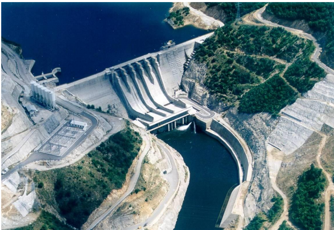
Σχήμα 3.4. ΥΗΕ Πλατανόβρυσης στον π. Νέστο.
