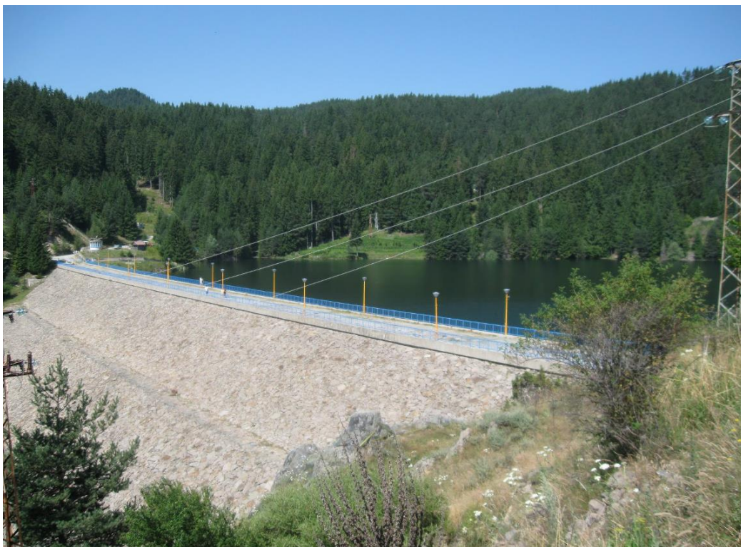
Σχήμα 3.6. Φράγμα Δεσπάτη π. στην Βουλγαρία.
