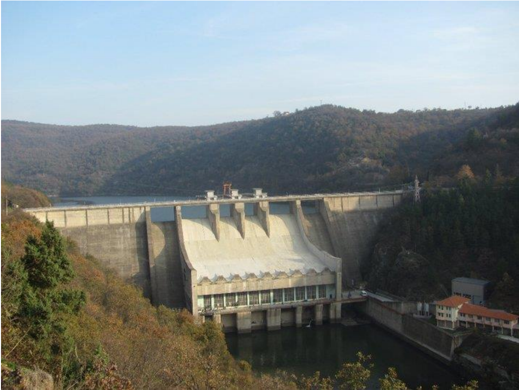
Σχήμα 3.7. Φράγμα Ιβαύλοβγκραντ επί του π. Άρδα, στην Βουλγαρία.
