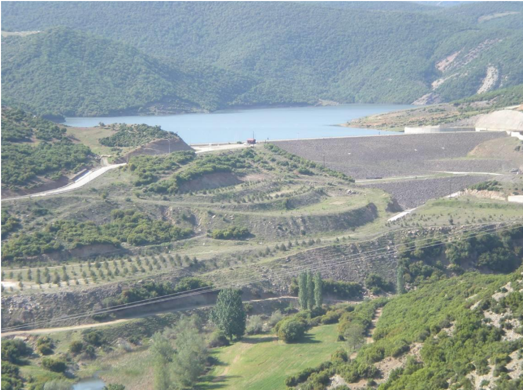
Σχήμα 3.8. Το φράγμα και η τεχνητή λίμνη της Γρατινής.
