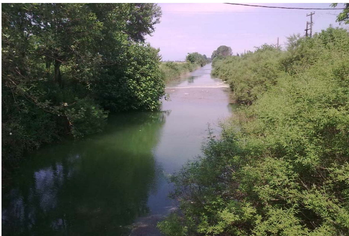
Σχήμα 4-5: Πλημμελής συντήρηση δικτύων που δημιουργεί μεγάλες απώλειες μεταφοράς
