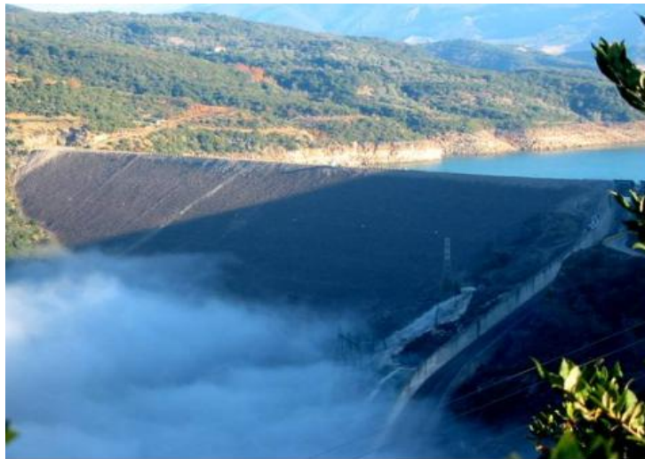
Εικόνα 3.2.1-2: Το φράγμα του ταμιευτήρα Κρεμαστών
