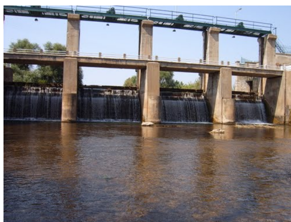
Σχήμα 3-6. Αρδευτικό φράγμα Πάμισου π. στον οικισμό Άρι
